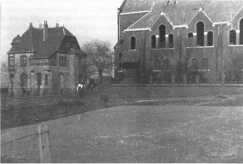
Das alte Pfarrhaus neben der beschädigten Kirche.
