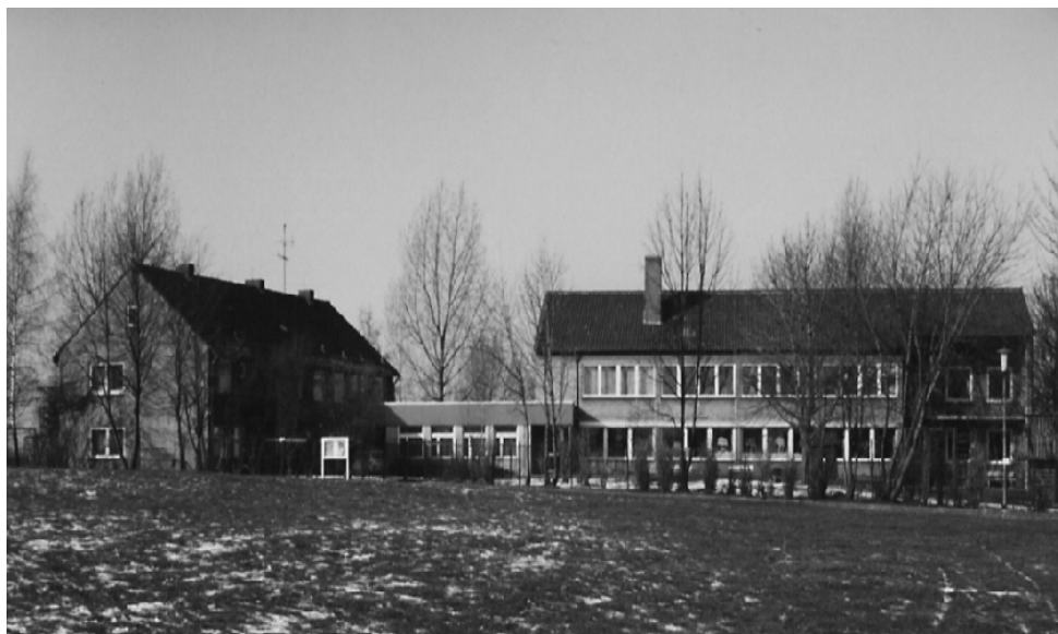
Das Gemeindezentrum Am Broch/Wagenfuhr mit (v. l. n. r.) Pfarrhaus, Gemeindeamt, Vikars- und Küsterwohnung, Gymnastikraum (angebaut) und Gruppenräumen des Ev. Kindergartens und Jugendräumen
