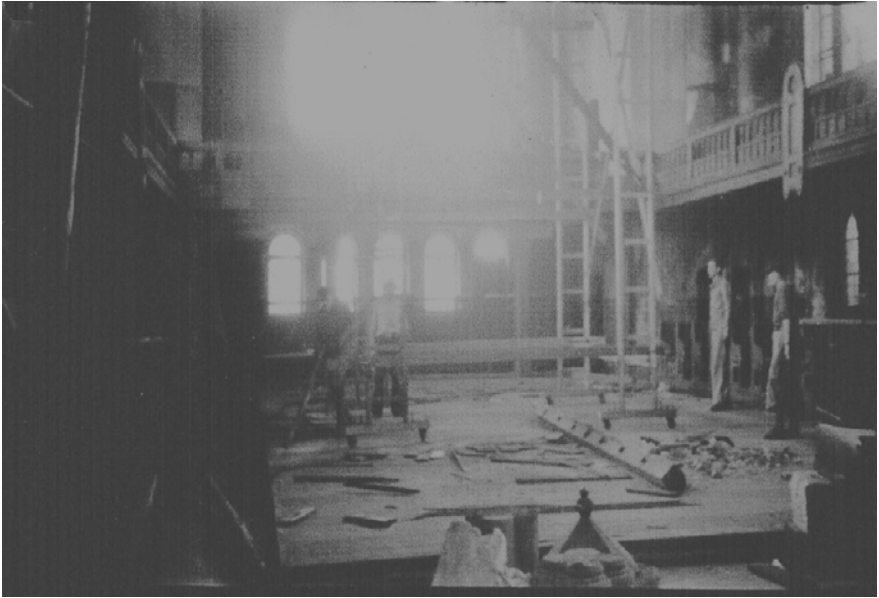
Renovierungsarbeiten 1950/51 Blick vom Altarraum zur alten Bücherei.
